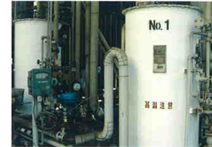
放熱防止、劣化防止
