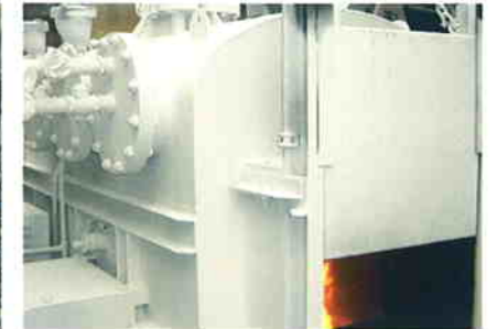
保温、火傷防止、劣化防止
