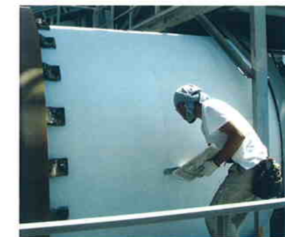
ドライヤーの外壁をコテ塗り
