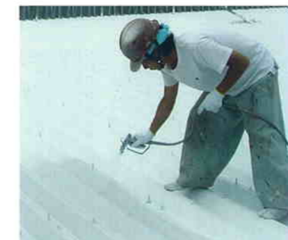
屋根をスプレー塗り
