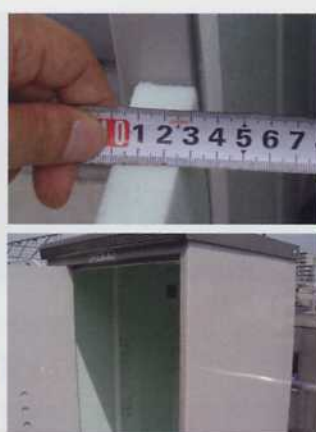
▲断熱材物置には、厚さ25mmのスタイロフォームを、天井、内壁、扉部分に貼り付けた。
