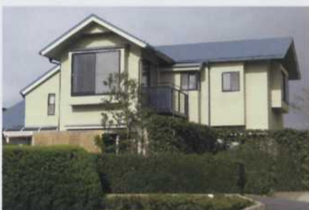
▲住環境の改善を図るため、築15年の戸建て住宅の屋根、外壁にガイナを塗布。
